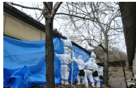
畜舎へのブルーシート設置
