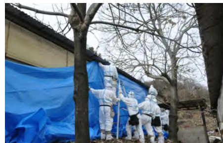
畜舎へのブルーシート設置
