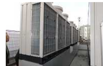
損傷・異音・異常振動の有無の確認
