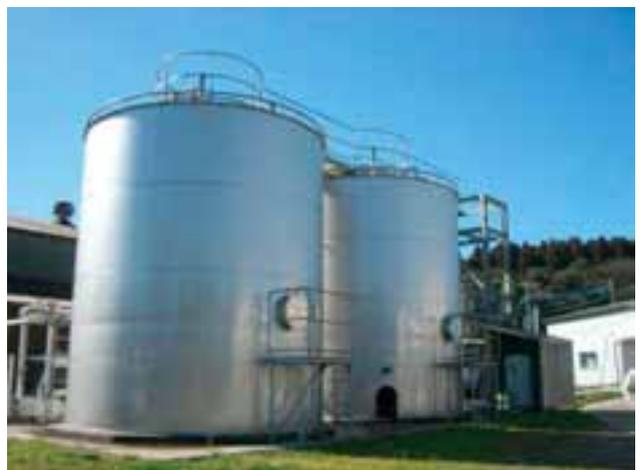
写真3 焼酎粕を使用したリキッドフィーディングと焼酎粕のタンク
