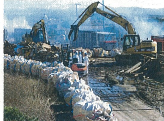
焼却作業中のヤードの様子
