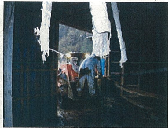
重機を用いて糞乾ベルトを撤去
