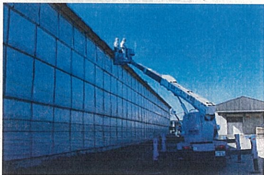
高所作業車を用いた高所への目張り
