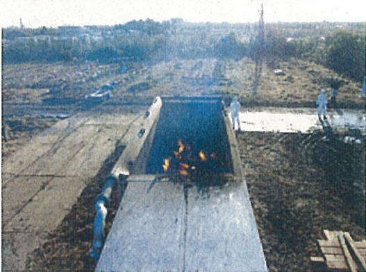
設置後の焼却ヤードの様子
