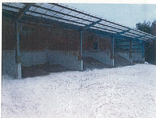
堆肥舎周辺への消石灰の散布
