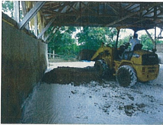
重機を用いて鶏糞を広げる
