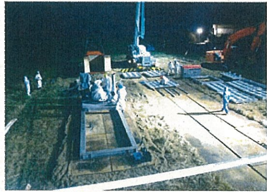
焼却炉の設置作業
