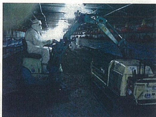
重機を用いて鶏糞をそぎ取り、 クローラーカート(運搬機)で運搬
