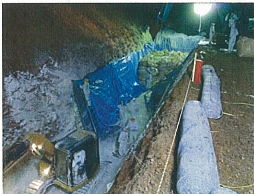
埋却溝への汚染物品の設置
