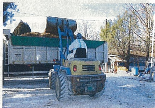
ダンプへの積み込み
