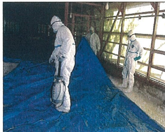
ブルーシートなどを消毒しながら作業
