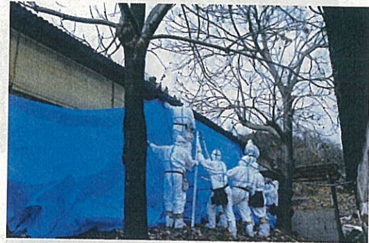
飛散を防止するための鶏舎の目張り
