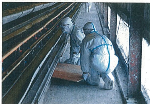
鶏糞ピットをコンパネで覆う① (鶏糞の拡散防止措置)
