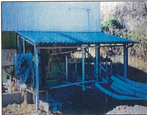
鶏糞ボイラー施設外観
