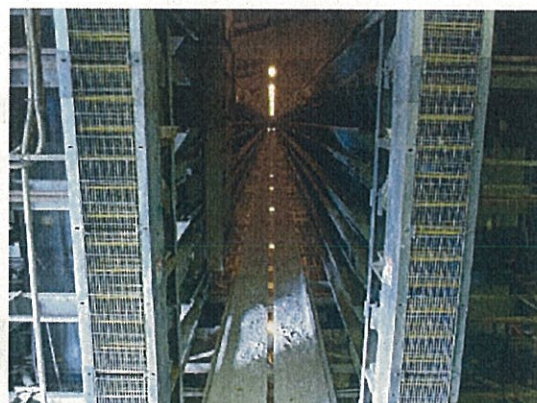
消石灰を散布した後の様子
