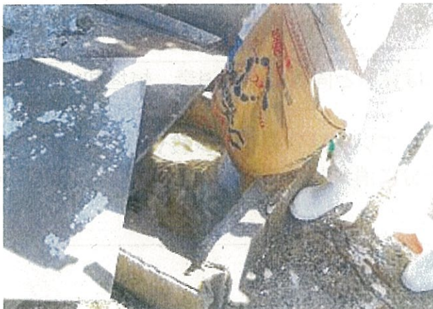
貯留槽へのクエン酸の投入
