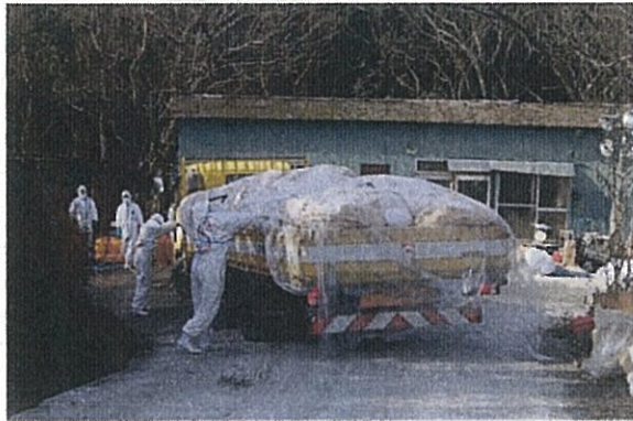
運搬車両をシートで覆う
