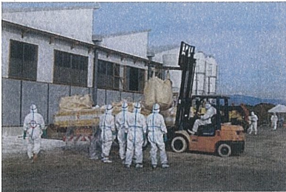
搬出用容器を運搬車両へ積み込み
