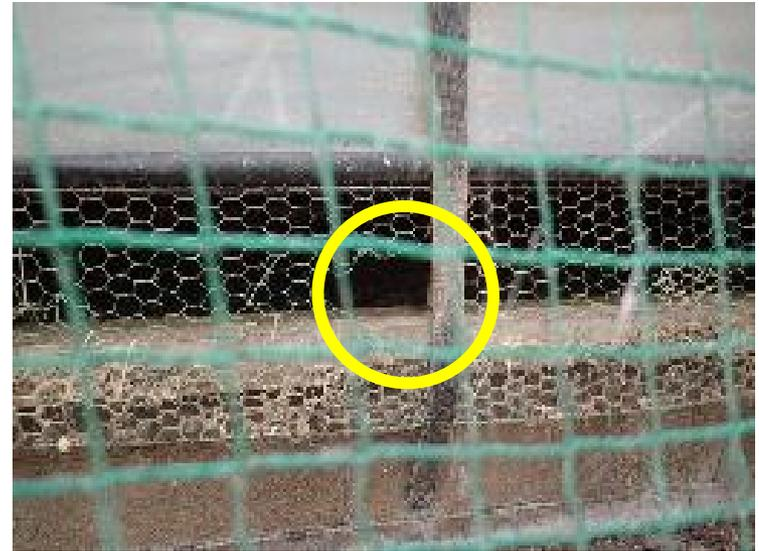
家きん舎側面の金網の破損
