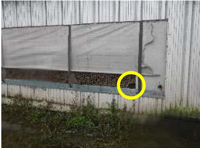
家きん舎側面の金網の破損
